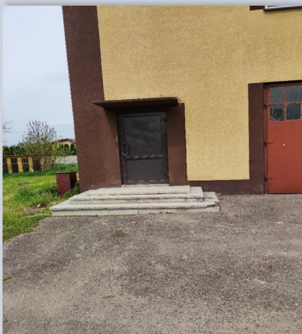
Zdjęcie 3: Przebudowa wejścia do remizy OSP Kostrzyna
