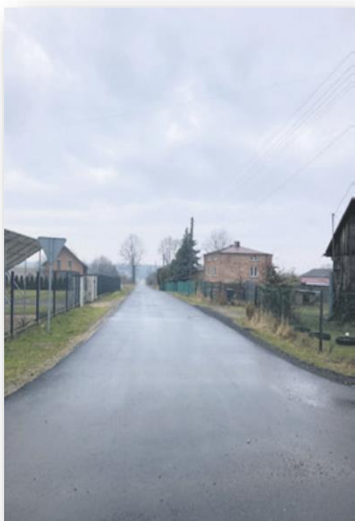
Zdjęcie 18: odbudowę konstrukcji drogi wraz z wykonaniem nawierzchni
