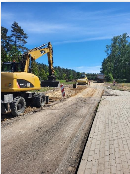
Zdjęcie 21: odcinek drogi przy PSO MASKPOL
