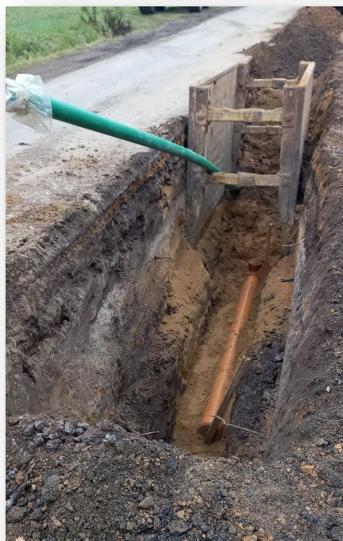
Zdjęcie 19: budowy sieci kanalizacji sanitarnej w miejscowości Konieczki
