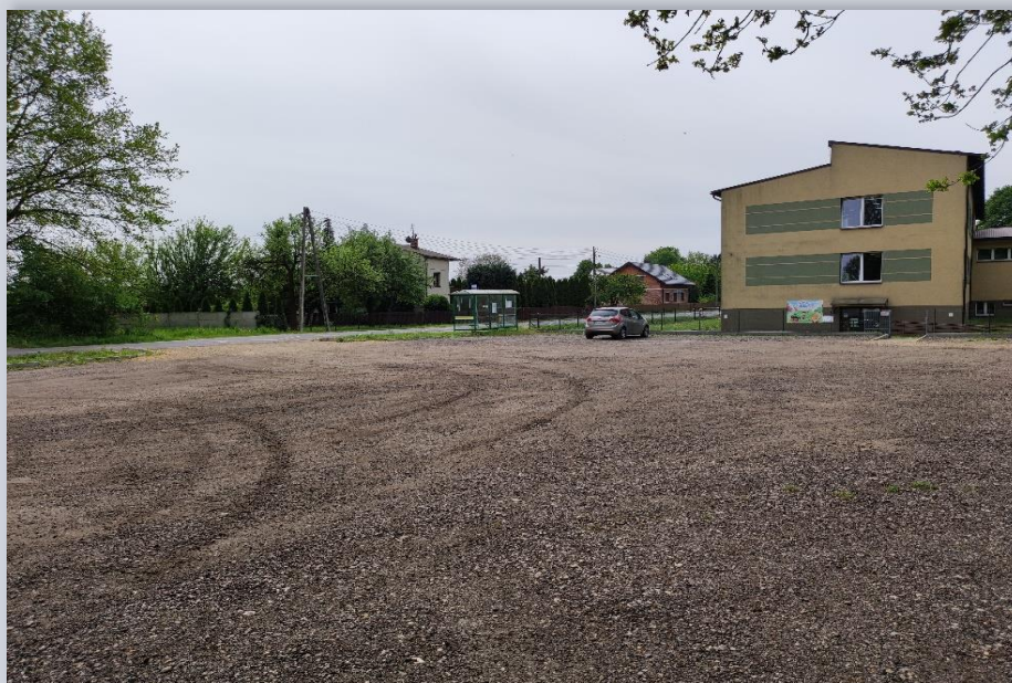
Zdjęcie 6: Utwardzenie placu przy Szkole Podstawowej w Konieczkach
